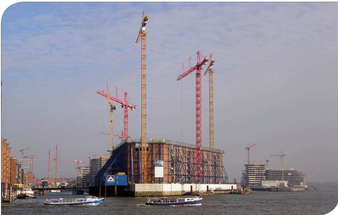
Abb. 1: Die Baustelle der Elbphilharmonie in Hamburg im Oktober 2008. Allein für die Herstellung des verbauten 63.000 m 3 Transportbetons (s. Text) wurden rund 41.000 t Bausand hoher Qualität benötigt, Foto: Emma7stern/Wikipedia .
